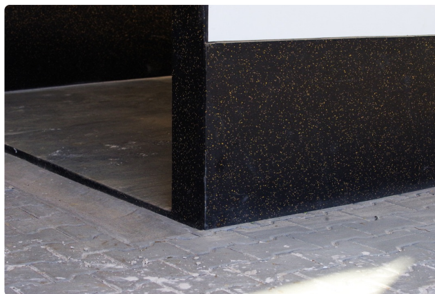
Wykładzina podłogowa i okładzina ścienna zamontowane w jednym boksie.
